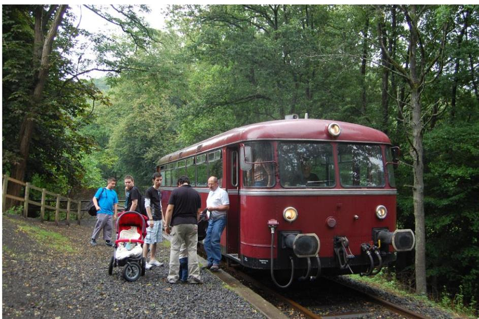
Bild 9: Beispiel für einen mit einfachen Mitteln (Altschwellen, Schotter, Split) hergestellten Bahnsteig für einen touristischen Halt an der Kasbachtalbahn.
